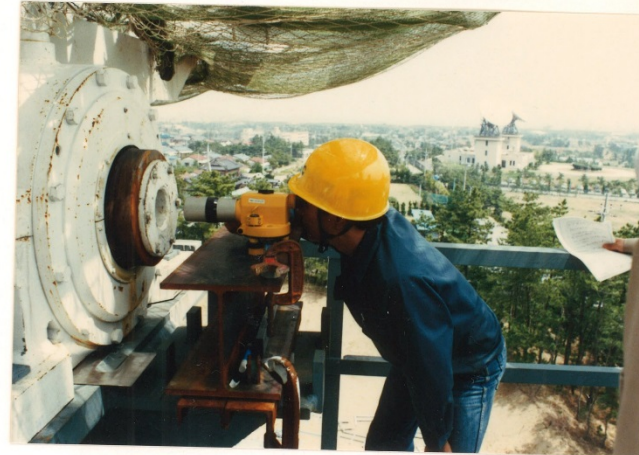
主鏡取り付け部の調整
