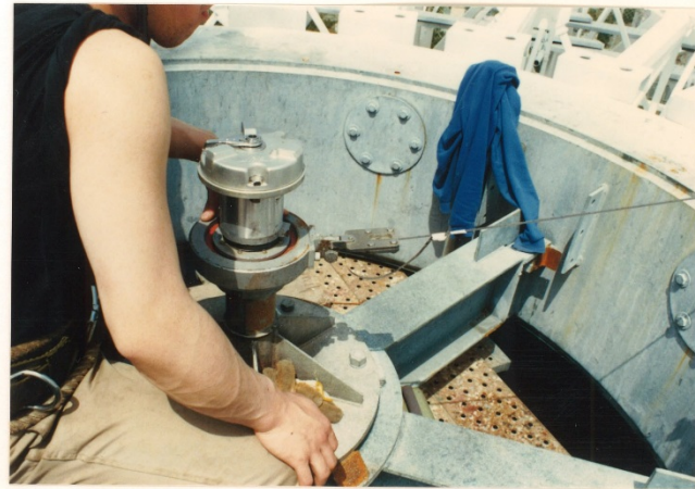
主鏡取り付け部の調整
