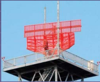
空港監視レーダー
