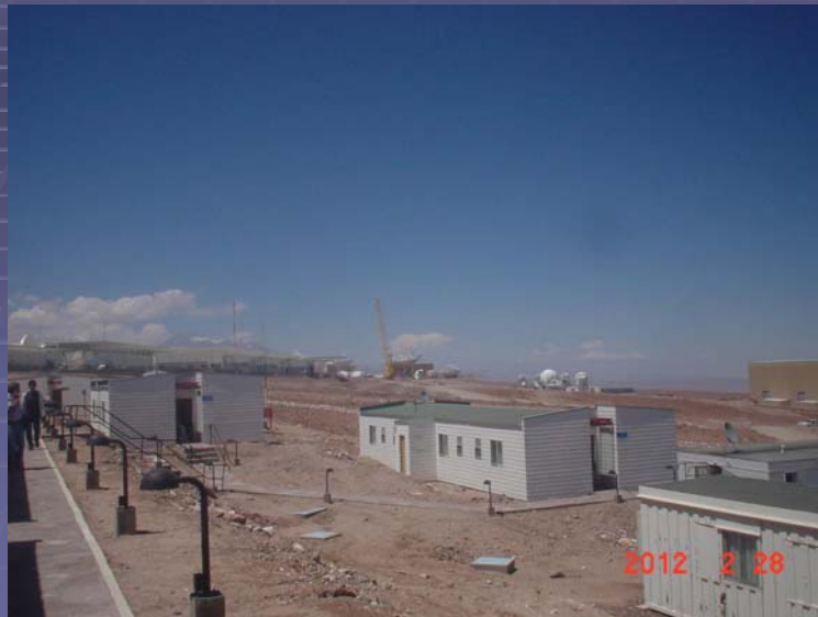
ベースキャンプの全景(手前のコンテナハウスで生活)
