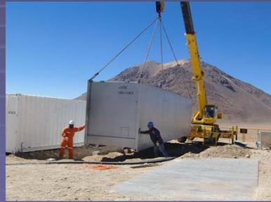
2010年1月の作業：観測用コンテナを設置し、ケーブルを敷設
