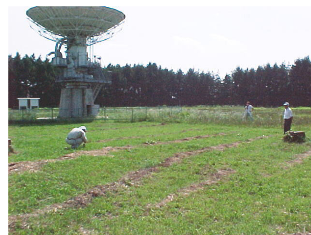
水沢20mアンテナ設置位置に杭打ちをしている様子。後ろに見えるのは水沢10mアンテナ。（7月31日）
