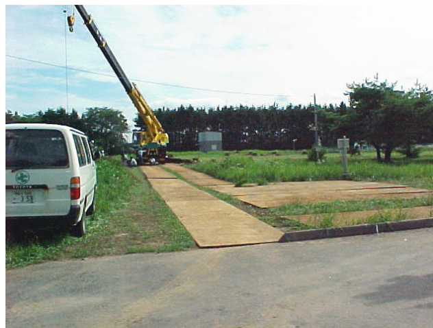
水沢局構内での鉄板敷設作業の様子。資材搬入や重機の通行用に使われる。（7月27日）
