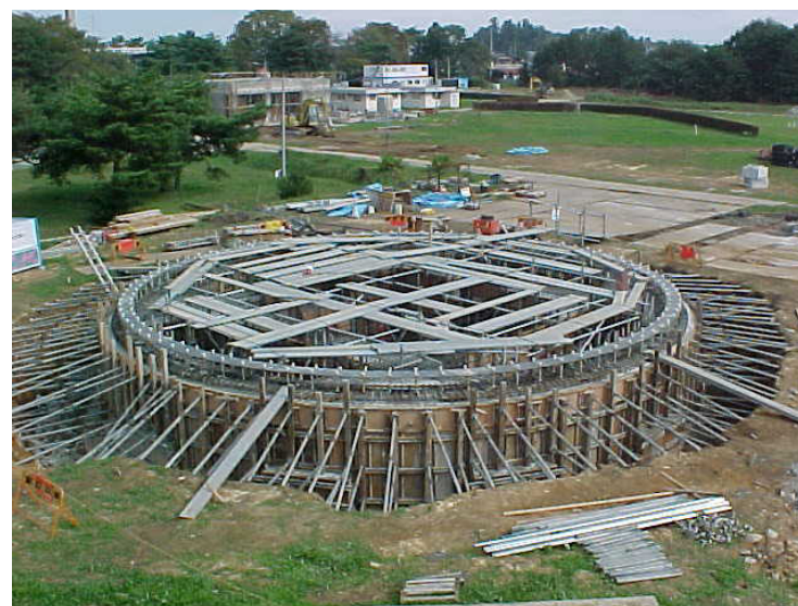
水沢局（国立天文台水沢観測センター）の様子。 入来局とほぼ同様な状態にある。奥には観測棟 工事現場も見える。
