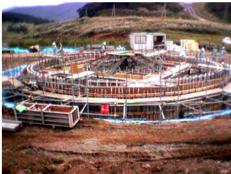
入来局（鹿児島大学入来牧場）の基礎工事現場。 コンクリート打設が終わって間もない状態。
