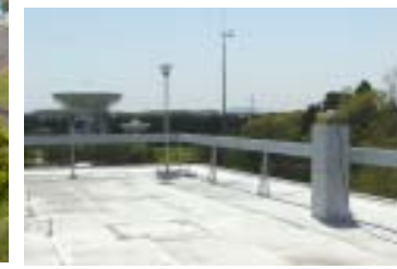
水沢局本館屋上のアンテナとGPS
